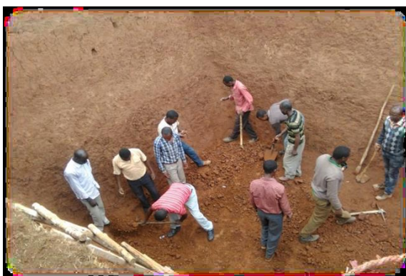
Inwoners van het dorp helpen mee bij de bouw van regenwateropvang en -opslag
